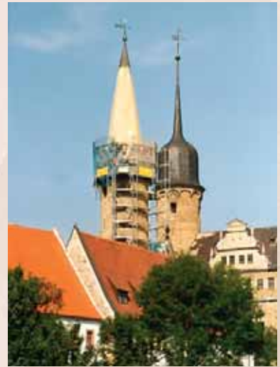
Sanierungsarbeiten am Süd-Ostturm
